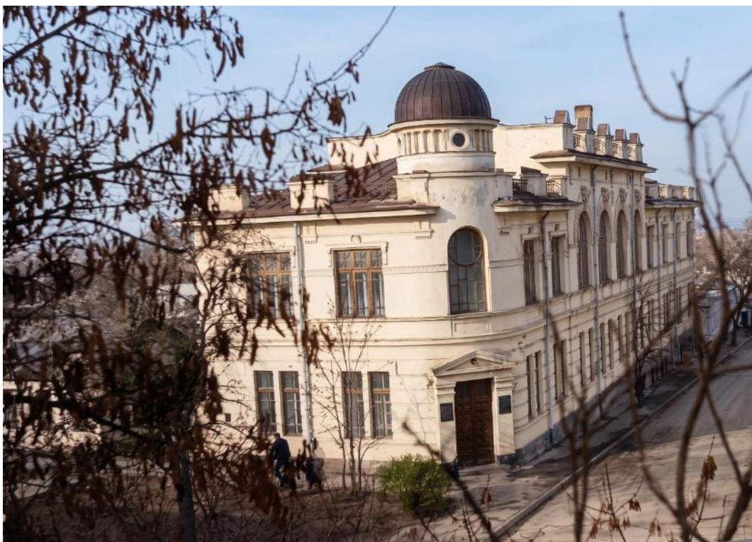
Рис. 34. Здание Талмуд-Торы – основной корпус факультета физического воспитания КГПИ им. М. В. Фрунзе. 1970–1980-е гг.
